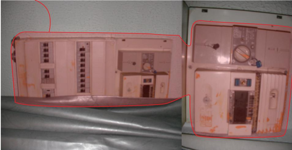
Tableau électrique et compteur - Système heures pleines/heures creuses
